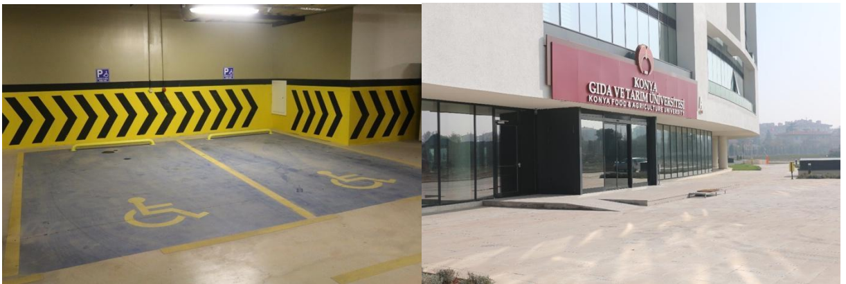
Şekil 7.6 Merkez Bina–Kapalı Engelli Otoparkı ve Merkez Bina– Giriş Kapısı Rampa
