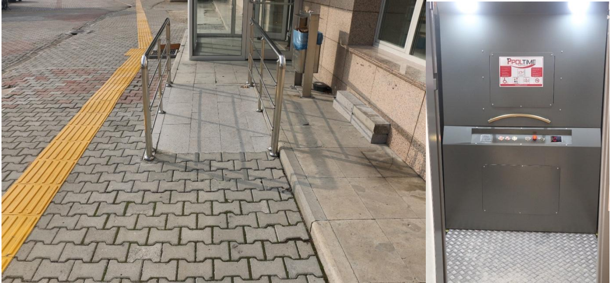
Şekil 7.2 Rektörlük Binası–Engelli Kullanımına Uygun Asansör ve Rektörlük Binası–Rampa
