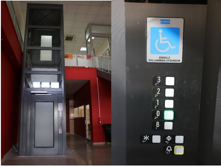
Şekil 7.4 Kütüphane– Engelli Kullanımına Uygun Asansör ve Merkez Bina– Sesli Uyarıcılı Engelli Kullanımına Uygun Asansörler, Braille Rakamlı Tuşlar
