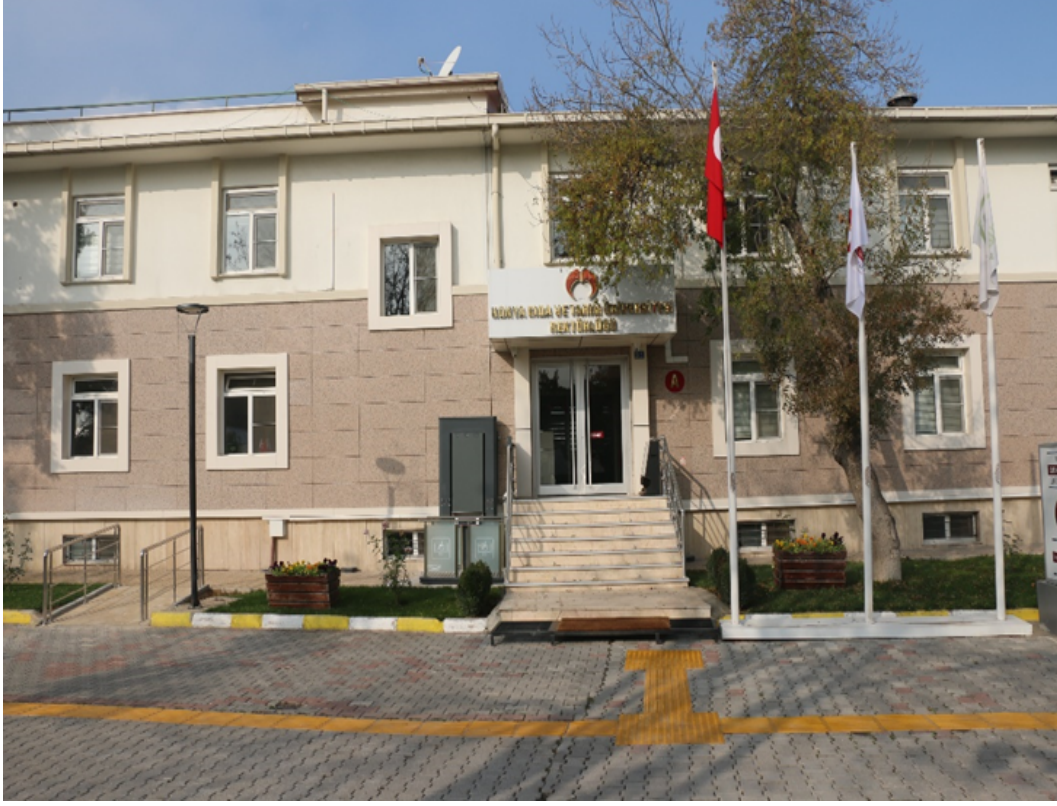
Görsel 2: Rektörlük Binası– Hissedilebilir Yürüme Yüzeyi, Rampa, Engelli Kullanımına Uygun Asansörler
