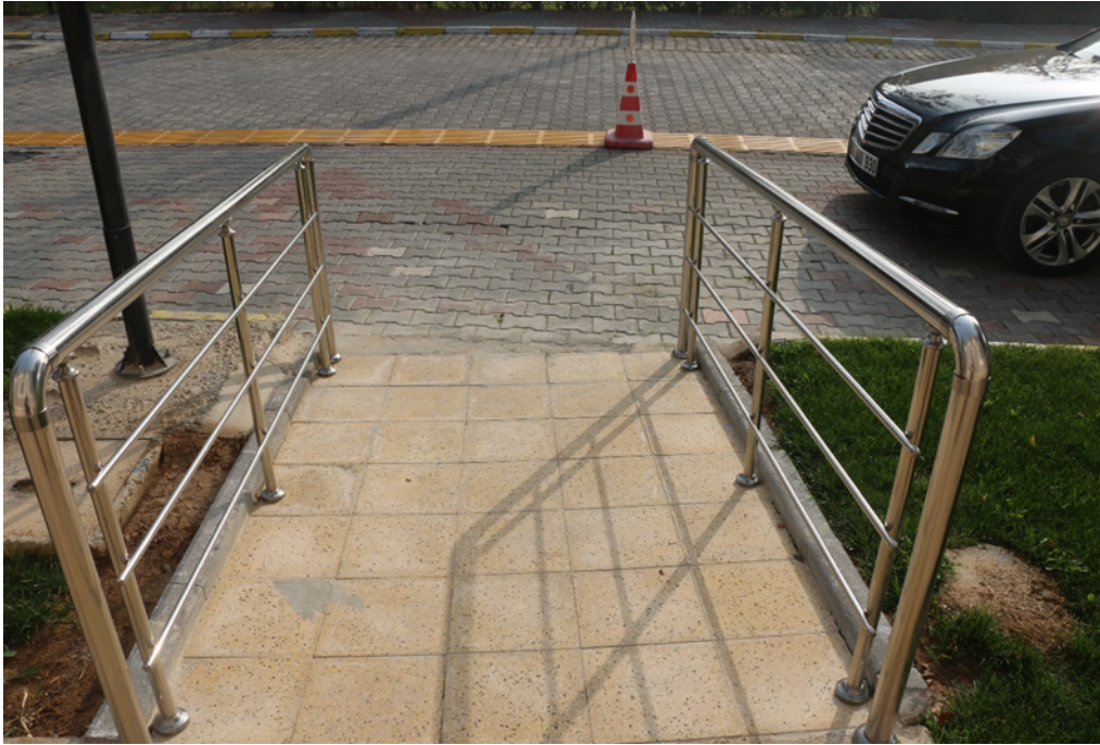
Görsel 5: Yabancı Diller Binası–Rampa
